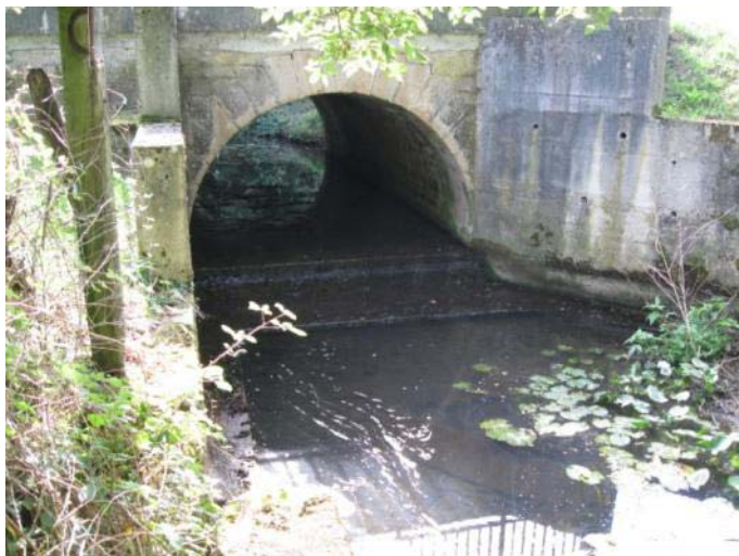
PHOTO 119 : LE RADIER DU PONT DE LA D1A CONSTITUE UN OBSTACLE INFRANCHISSABLE À LA REMONTÉE.
