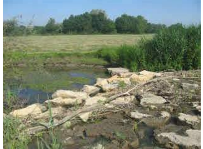
Seuil de dérivation vers le bief de la morte en amont du moulin Bruno (RE8a). Pas de connectivité piscicole possible hors crues.
