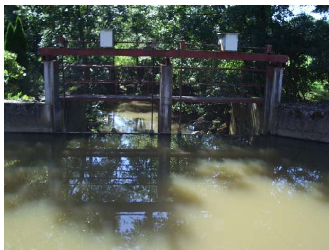
Vannes guillottes électrifiées en position basse (étiage)
