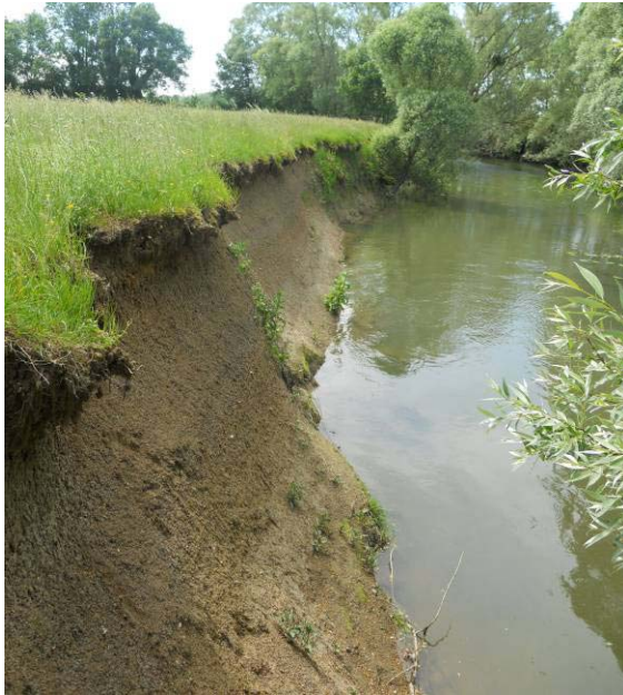
B2) Déstabilisation d'une partie de berge sur le RE8c influencé par le remous de l'ouvrage de St Julien
