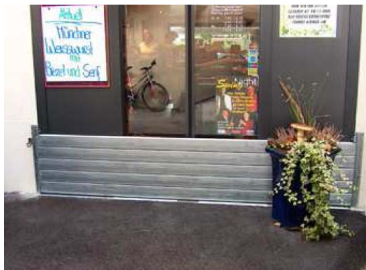
Exemple de protection par batardeaux mis en place devant une vitrine
