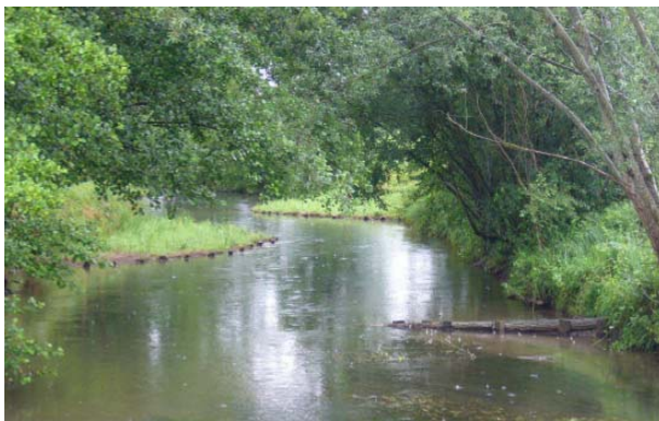
Exemple de réalisation de banquettes alternées et de lit emboîté
