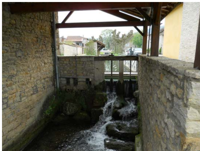
Petite vanne guillotine sur le seuil (vue aval)
