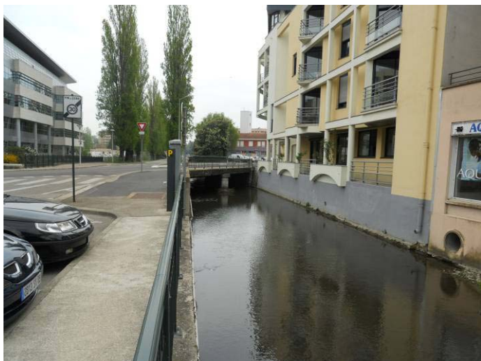
Canal des moulins - Ouvrage en aval du moulin des Halles en charge pour la Q50 – Débordements en rive gauche vers le champ de foire
