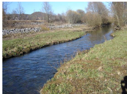
Exemple de réalisation de banquettes alternées et de lit emboîté
