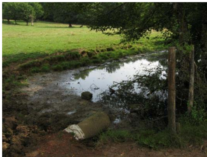
PHOTO 72 : PASSAGE BUSÉ ROMPANT LA CONNECTIVITÉ LONGITUDINALE AU NIVEAU D'UN FRANCHISSEMENT POUR LE BÉTAIL.
