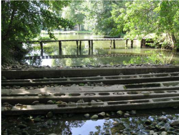
PHOTO I 21 : EXUTOIRE DE L'ÉTANG DES CACHETS. L'OBSTACLE EST INFRANCHISSABLE HORS HAUTES EAUX.
