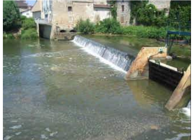
Seuil et vanne clapet de Pont-de-Vaux.
