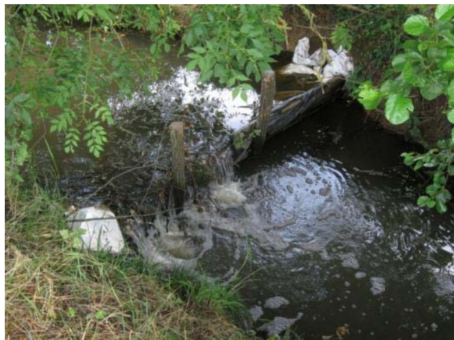
PHOTO 56 : SEUIL EN PLANCHES VISANT À MAINTENIR LE NIVEAU DANS LES ABREUVIERS SITUÉS À L'AMONT.
