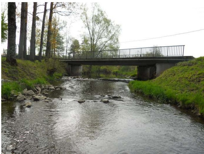
Pont de Noirefontaine suffisamment dimensionné pour la Q50
