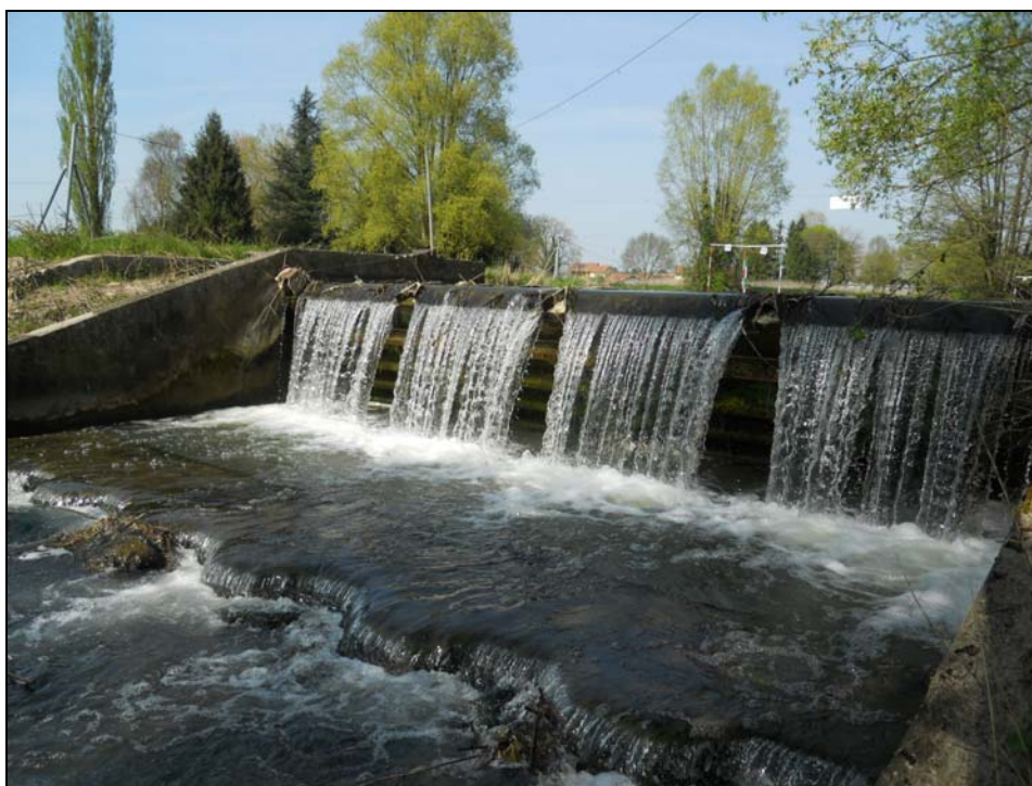
Vanne clapet automatique du moulin de Curtafray
