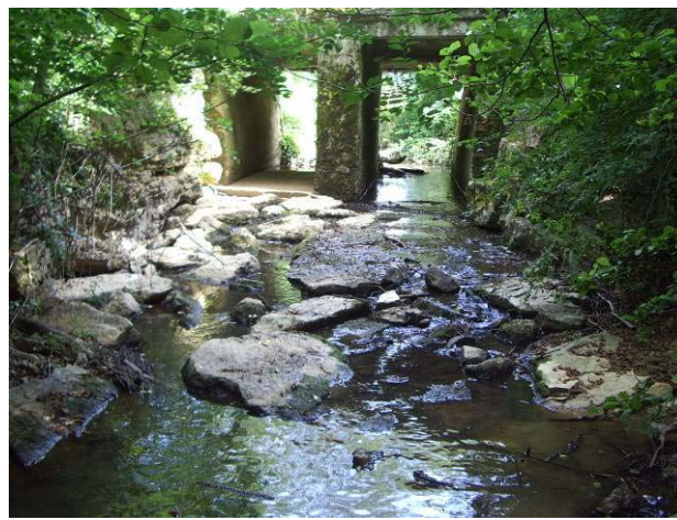
Affouillement en aval des ouvrages de franchissement sur le Reyssouzet (conforté par enrochements en aval du pont de Curlin)
