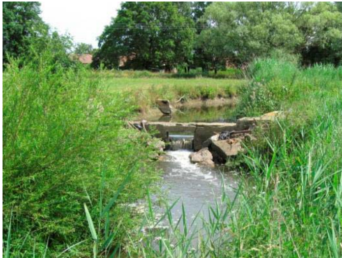
PHOTO 13 : SEUIL DE DÉRIVATION À L'AMONT DE LA MORTE.
