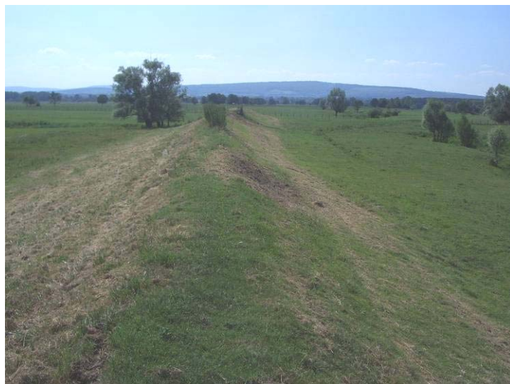
Reryssouze.- Digue de casiers dans la plaine inondable de la Saône
