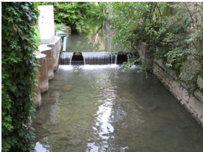
PHOTO 107 : VANNE CLAPET EN AMONT DE L'AVENUE MAGINOT. CET OBSTACLE MOBILE NE CONSTITUE PAS UNE RUPTURE PERMANENTE DANS LES POPULATIONS PISCICOLES.
