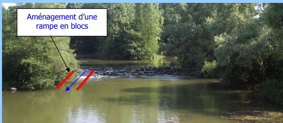
Rampe en blocs à aménager au droit du seuil de Corcelles
