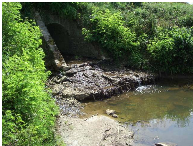
Affouillement en aval des ouvrages de franchissement sur le Reyssouzet (conforté par enrochements en aval du pont de Curlin)
