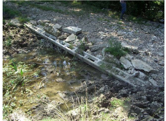
Points durs du profil en long du Salençon – Point de blocage du transit sédimentaire
