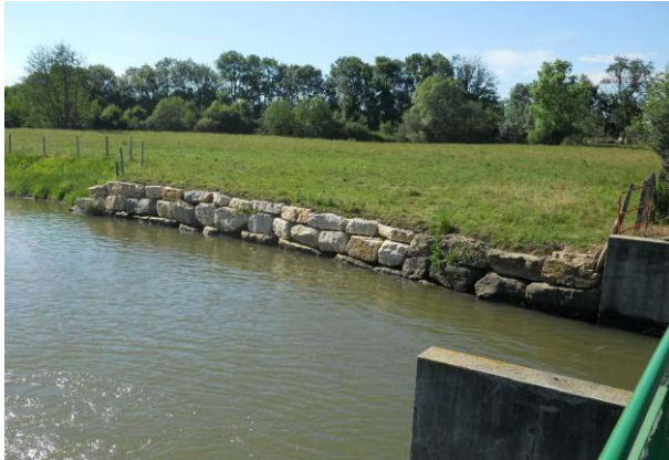
Type de berge T4 non érodable en raison de l'artificialisation des berges. Ici l'Ia Reyssouze en aval des vannages de St Julien
