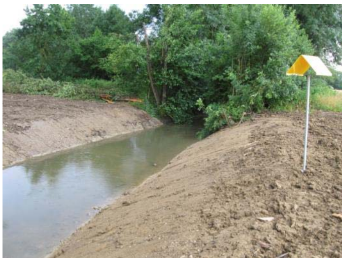
PHOTO 27 : BERGES RÉCEMMENT REMANIÉES PAR LE PASSAGE DU GAZODUC GRT.
