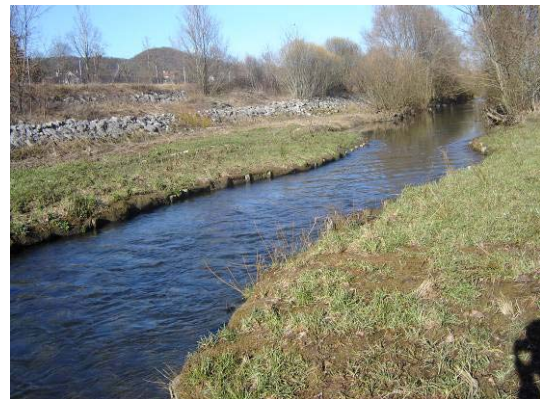
Exemple de réalisation de banquettes alternées et de lit emboité
