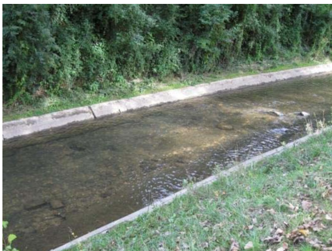
PHOTO 81 : DANS LES SECTEURS OU LE FOND EN BÉTON EST LE PLUS DÉTÉRIORÉ, LES SUBSTRATS SONT CONSTITUÉS DE GALETS.
