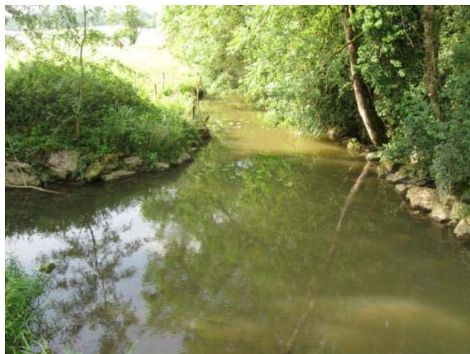
PHOTO 16 : PROTECTIONS DE BERGE EN ENROCHEMENTS ET ARBRES EN CONTACT À L'AMONT IMMÉDIAT DU PONT DE LA RD28.
