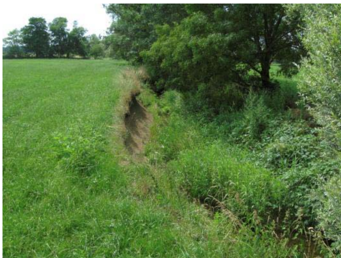
PHOTO 45 : BERGE EFFONDÉE DANS LE TRONÇON M6A.
