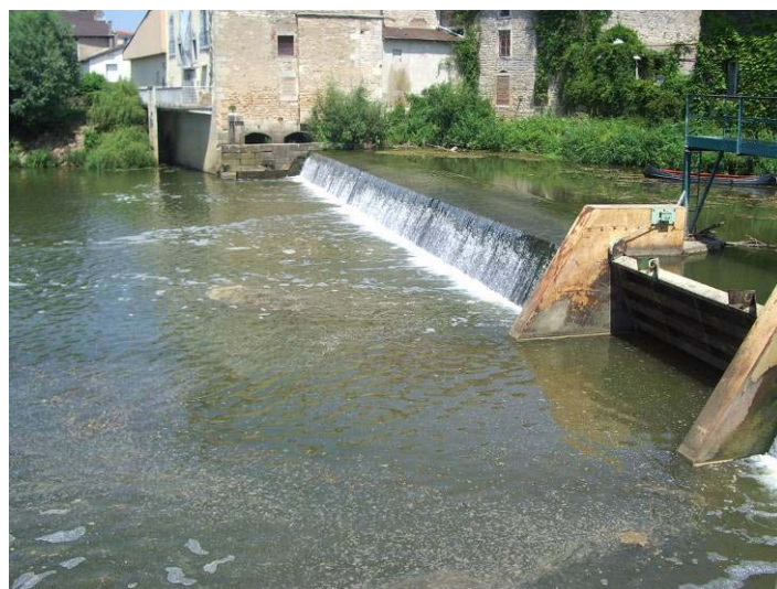
Pont de Vaux.- Seuil de Pont de Vaux noyé en cas de Q2 de la Saône
