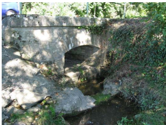
PHOTO 96 : FRANCHISSEMENT DE LA D979. LE BUSAGE SOUS LE DALOT PERMET À LA CONTINUITÉ BIOLOGIQUE D'ÊTRE ASSURÉE.
