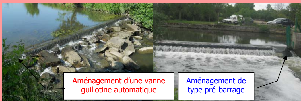
Vanne guillotine automatique et passe à poisson type pré-barrage au droit du moulin Riottier
