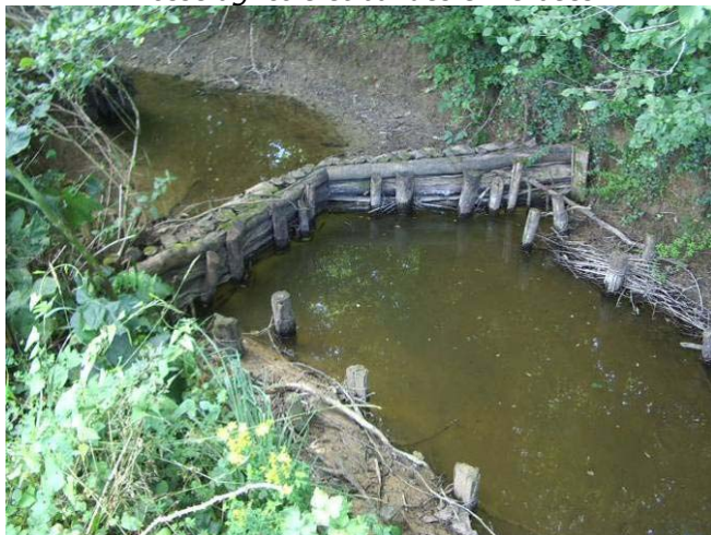
le bief d'Ouche (OU1b) en amont de Ouche – Seuil piscicole en bois contourné –écoulement quasi-nul
