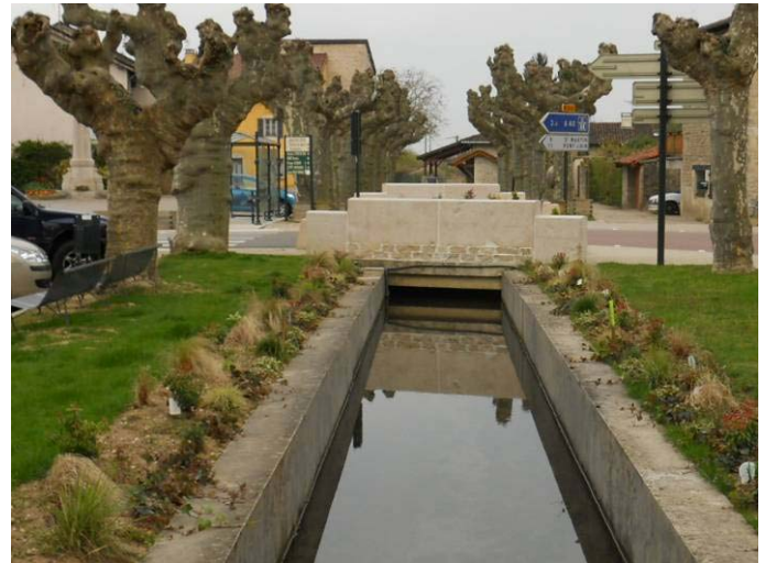
Ouvrage du centre village de Tossiat en charge et débordant pour la Q50
