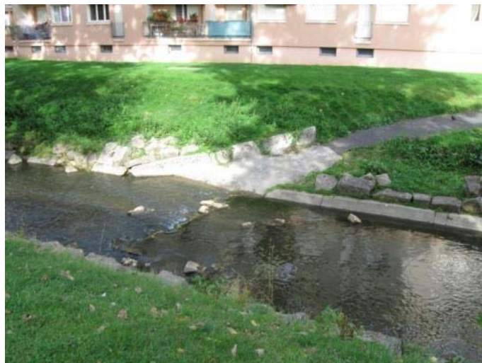
PHOTO 80 : SEUIL DE FAIBLE HAUTEUR SITUÉ À PROXIMITÉ DE LA PRISE D'EAU.
