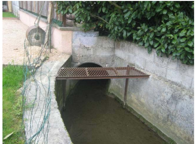
Buse au lieu-dit « les Saugniers » en limite de capacité pour la Q10
