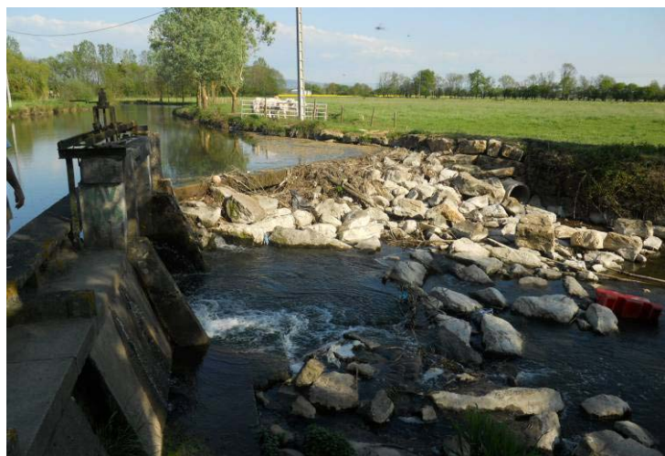
Déversoir fixe du moulin Peloux occasionnant un remous important en période de crue
