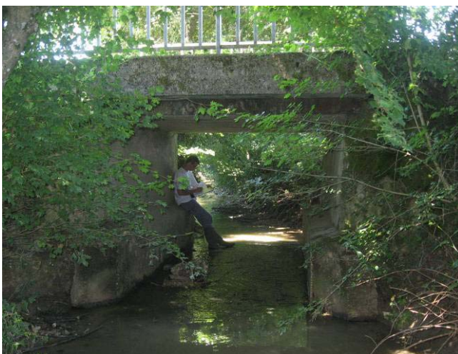
Marque d'incision du profil en long de la Gravière (Confortement de culée et végétation perchée)
