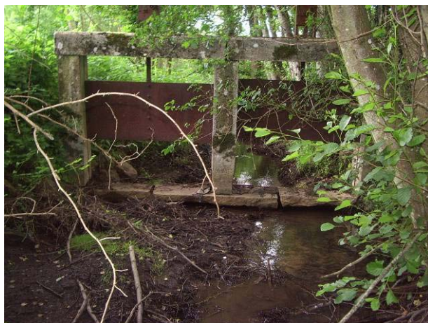
Points durs du profil en long de la Leschèze – Vannages de la Levée et de Donsonnas
