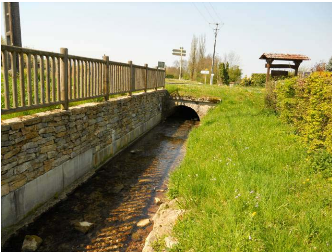
Ouvrage sous la RD52 à Journans en charge pour la Q50
