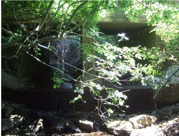
Points durs du profil en long du Salençon – Point de blocage du transit sédimentaire
